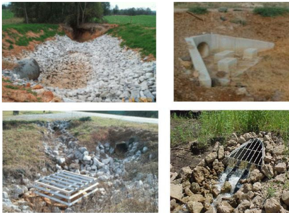
7 pav. Šlaitų sutvirtinimo ties išleistuvais galimi būdai
