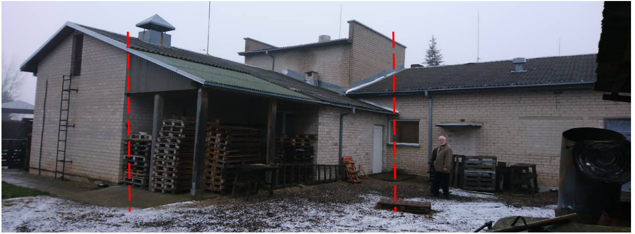
6 pav. Pastato vakarų-pietvakarių fasadas su neregistruotu priestatu Nr.2
