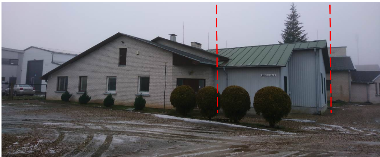
1 pav. Pastato rytinis fasadas su neregistruotu priestatu Nr.1
