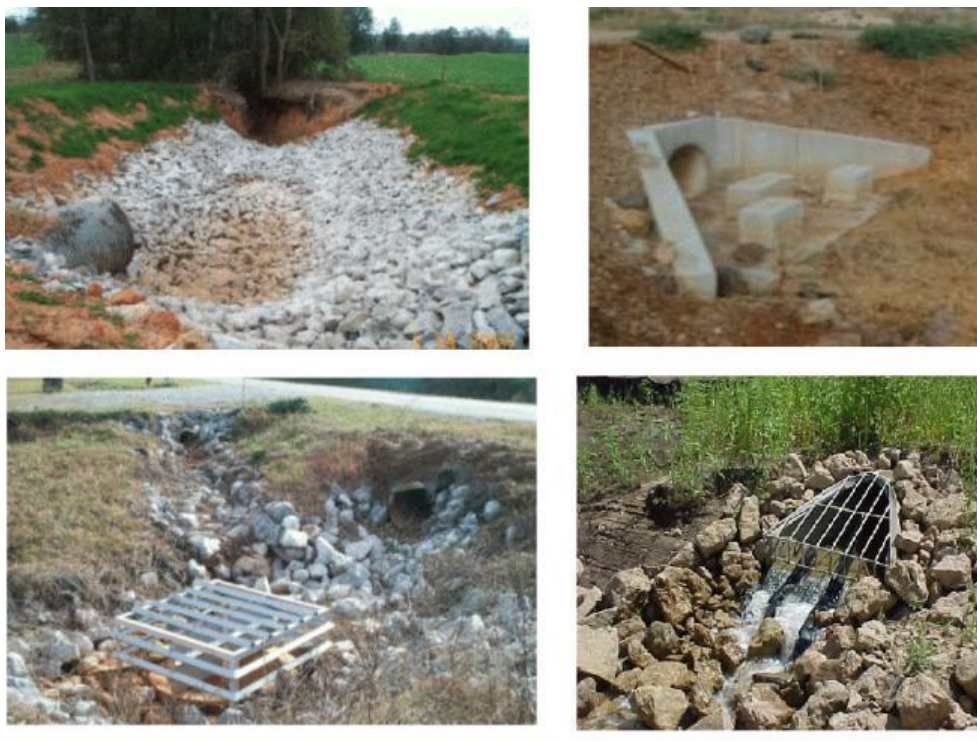
7 pav. Šlaitų sutvirtinimo ties išleistuvais galimi būdai
