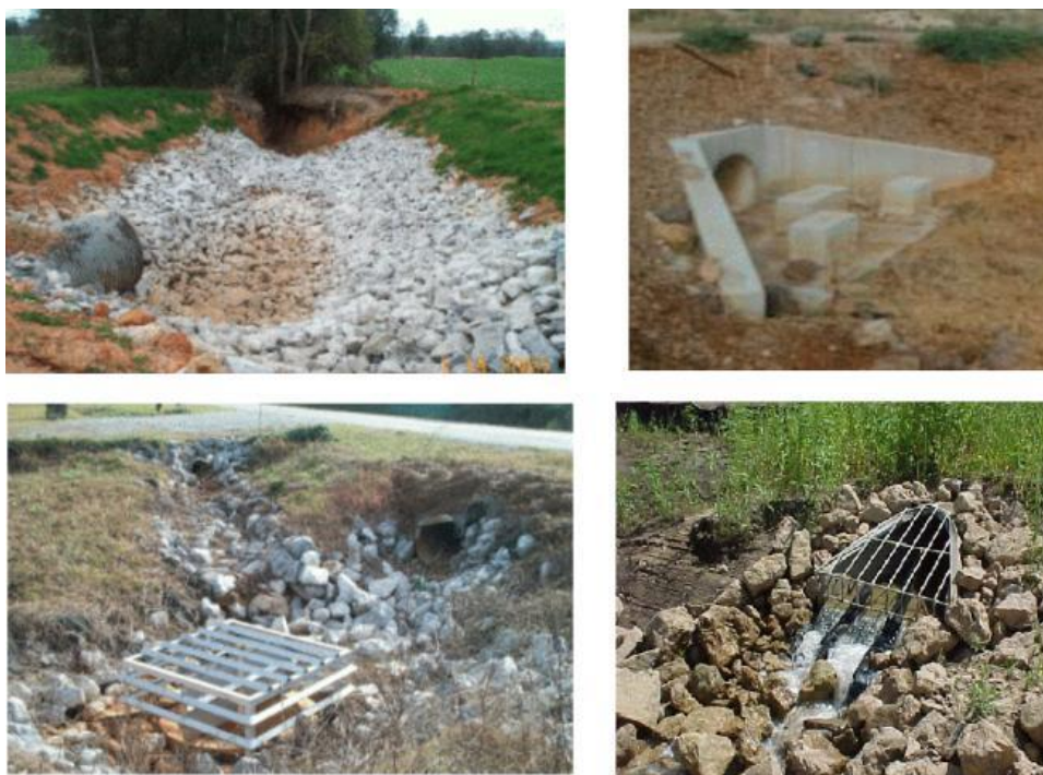
4.1. pav. Šlaitų tvirtinimo ir srauto slopinimo įrengimo variantai
