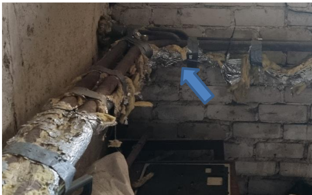
1 pav. Šildymo sistemos magistralių būklės fragmentas.
