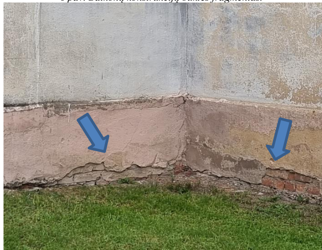
8 pav. Cokolio pažeidimų fragmentas. Neįrengta nuogrinda.
