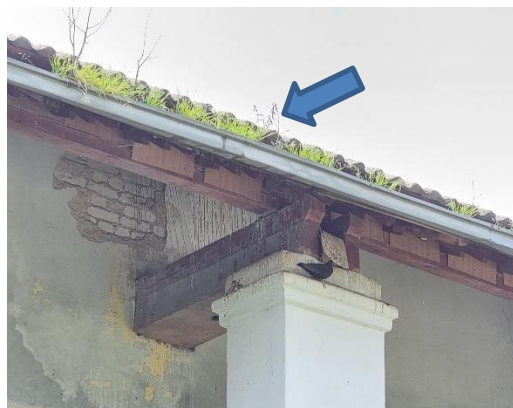
2 pav. Lietaus šalinimo sistemos būklės fragmentas.
