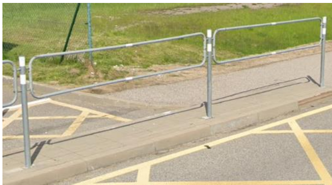
4 pav. Kelio apsauginė tvorėlė
