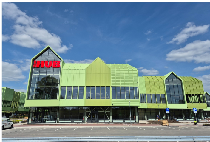
pav. 1 remontuojamas pastatas
