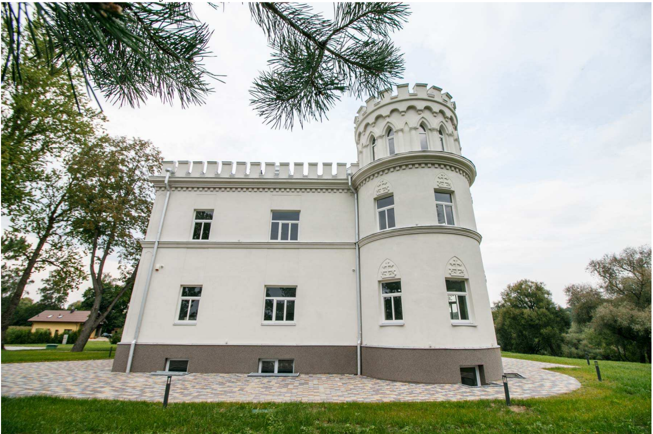
Foto fiksiacija nr. 1 Kačiūniškės dvaro pastatas
