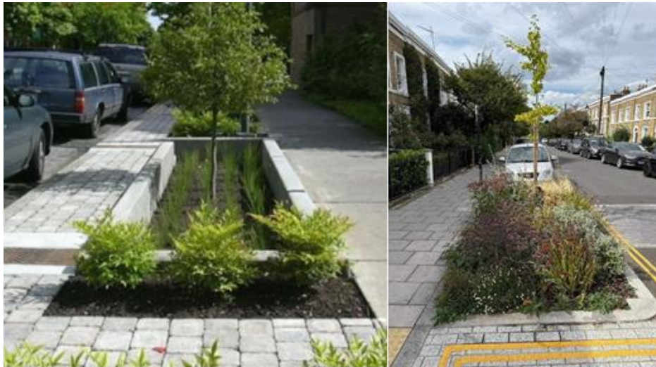
2.3 pav. Šlapbalių įrengimas gatvių erdvėje (šaltinis: Vilniaus miesto savivaldybės gatvių infrastruktūros standartas; https://www.ace-cae.eu/activities/net-arch-programme-and-eu-funded-projects/past-projects/connect-arch/20-projects-architectural-projects-against-climate-change/waterplein-bethemplein/ )
