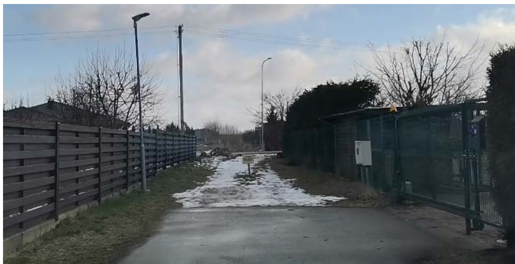
3 paveikslas. Narsiečių g. akligatvis - asfalto dangos pabaiga, PK 6+80
